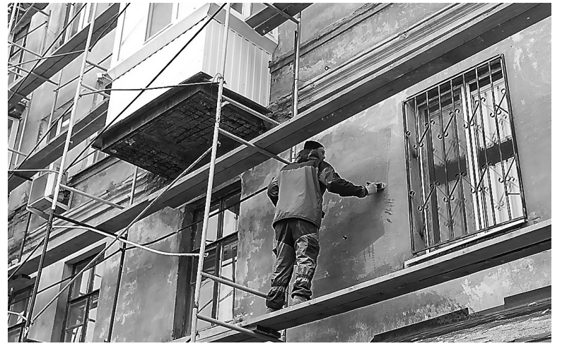
В этом году региональный оператор ведет ремонты в 34 тагильских домах. Подрядчики приступили к замене инженерных сетей и кровель еще в ноябре прошлого года, в апреле-мае перекрывают крыши, отделывают фасады. Строительно-монтажные бригады трудятся каждый день, без выходных, весь световой день.
