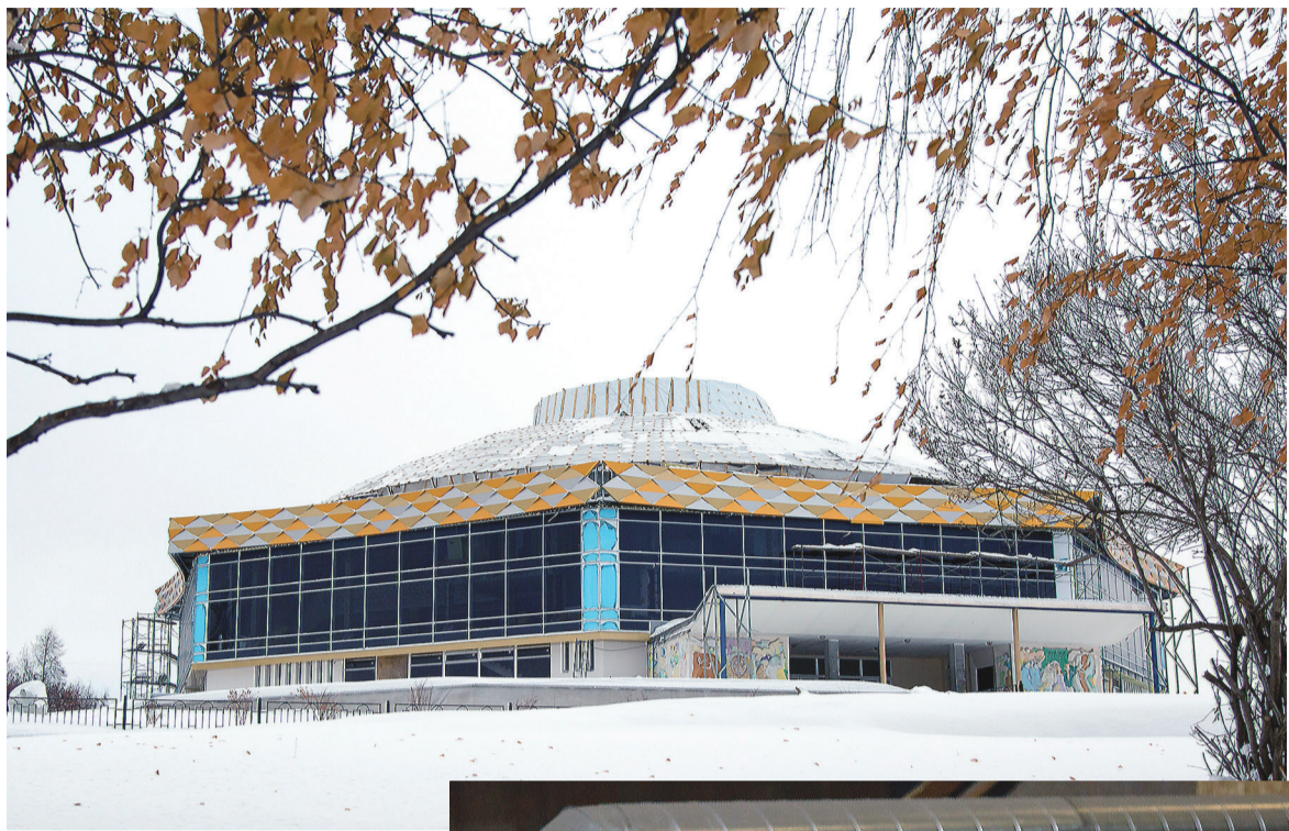
Часть наружных работ завершена.
