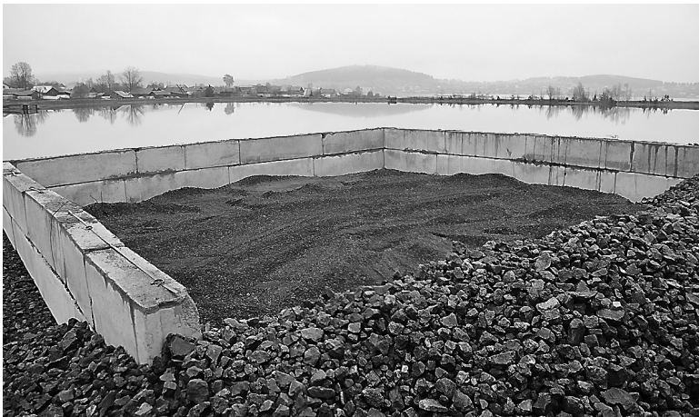
Бетонная ванна для очистки воды от шлама.
