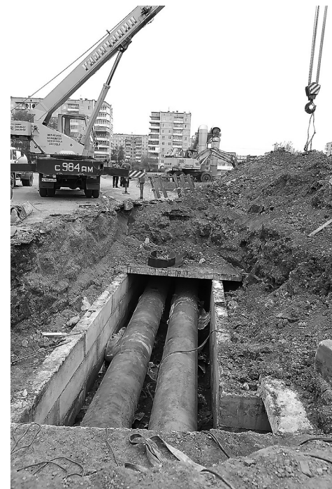
Ремонт теплотрассы на Октябрьском проспекте ведет МУП «НТТС». ФОТО СЕРГЕЯ КАЗАНЦЕВА.
