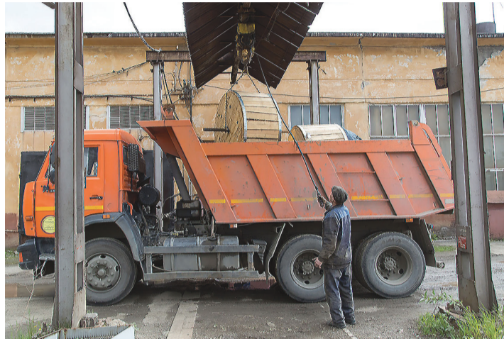
Идет разгрузка машины с катушками кабеля. ФОТО СЕРГЕЯ КАЗАНЦЕВА.
