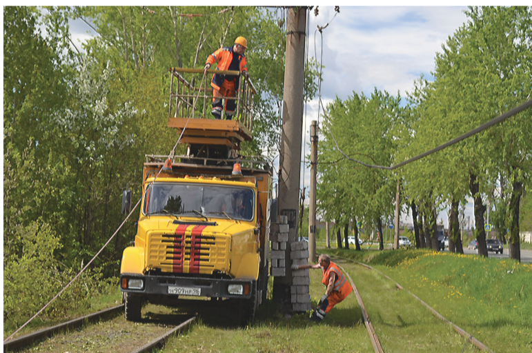
Монтаж контактного провода на Восточном шоссе.
