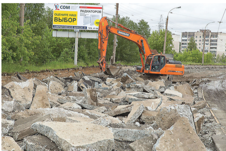
Демонтаж старого основания на Космонавтов.
