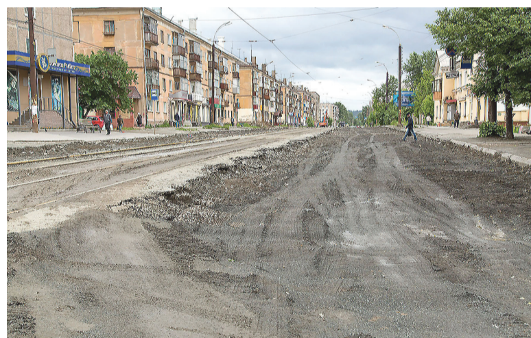
Асфальтовое покрытие снято (ул. Космонавтов).
