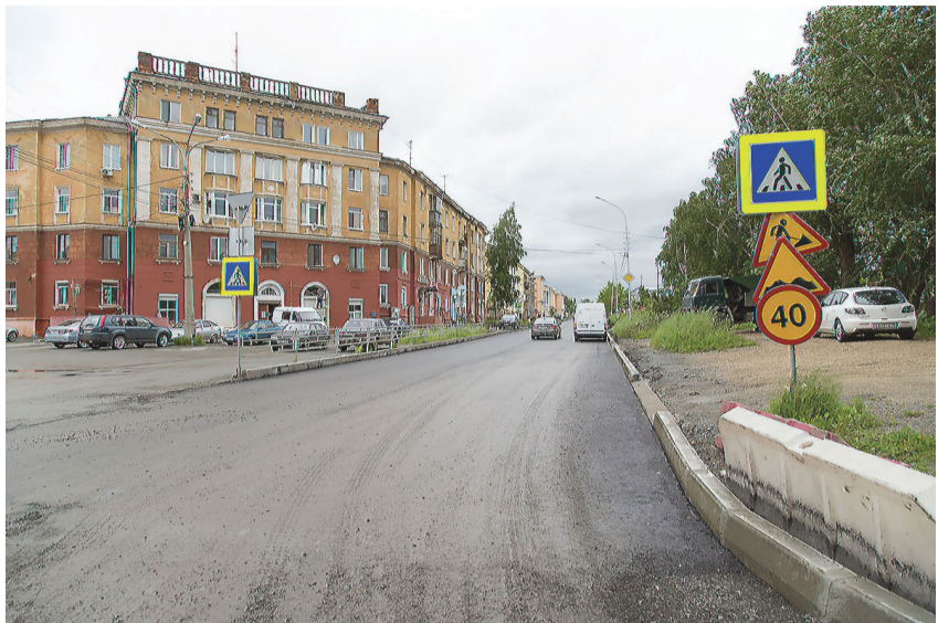
Новое дорожное полотно на улице Восточной.
