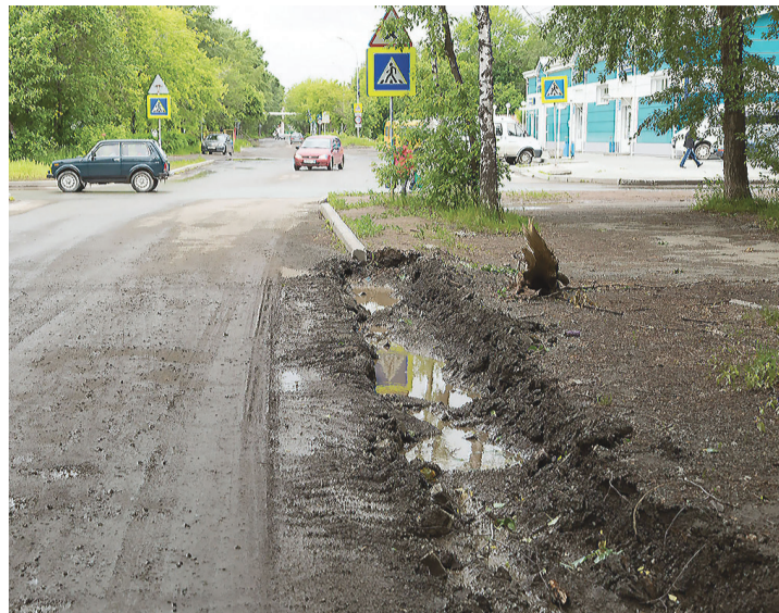
На улице Оплетина подрядчики начали установку бордюров.
