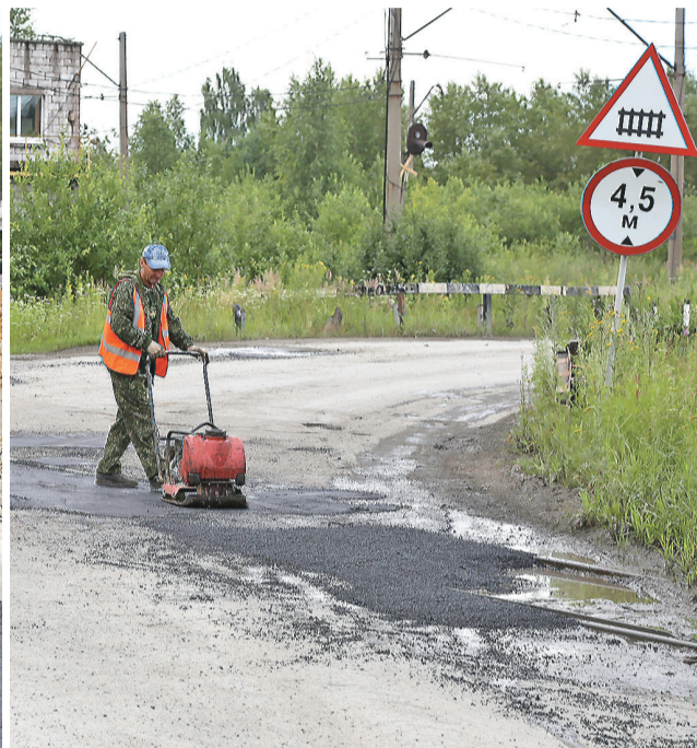
Ямочный ремонт на дороге к нефтебазе.
