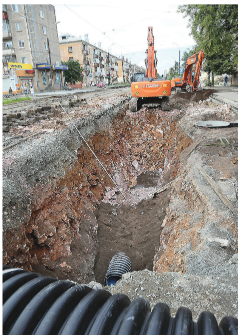
Монтаж ливневой канализации на улице Космонавтов.
