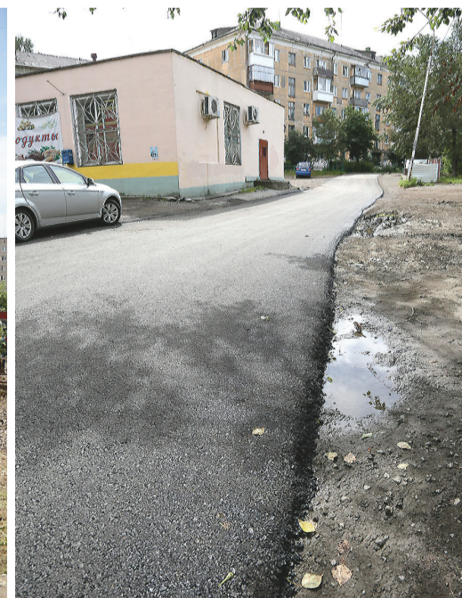
Заасфальтированный внутриквартальный проезд на Циолковского.
