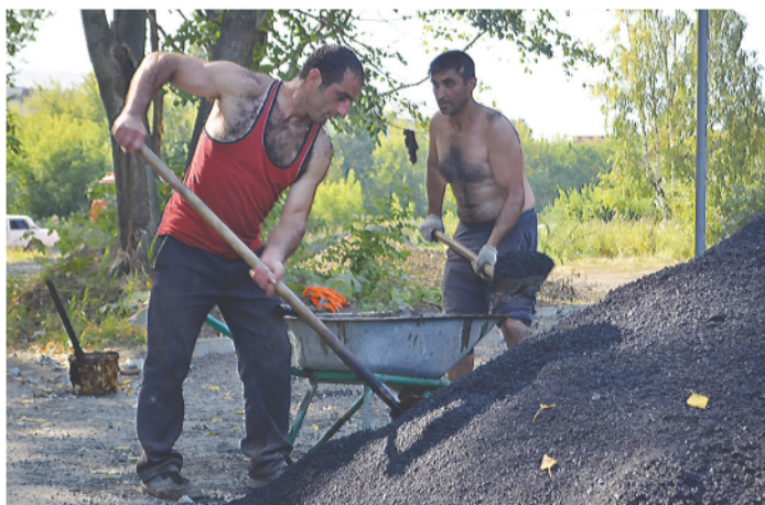
Ремонт тротуара на улице Черных.
