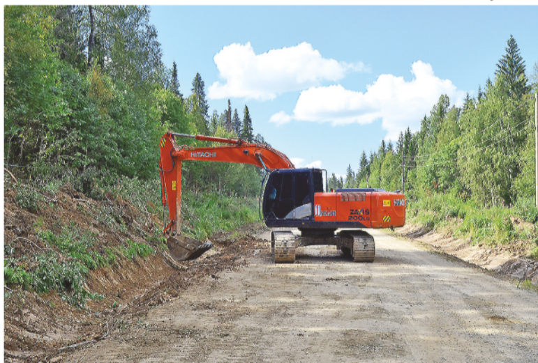
Прокладка дорожных канав.
