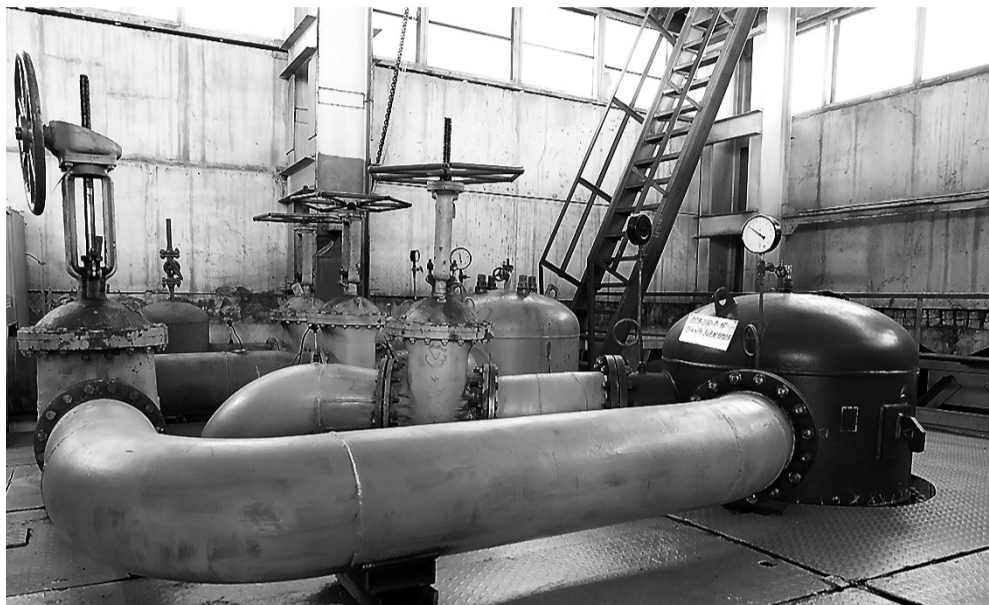
Подогреватель сетевой воды.
