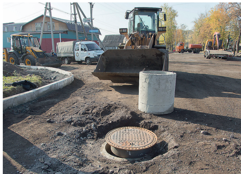
Ремонт на перекрестке улиц Черных и Максима Горького.
