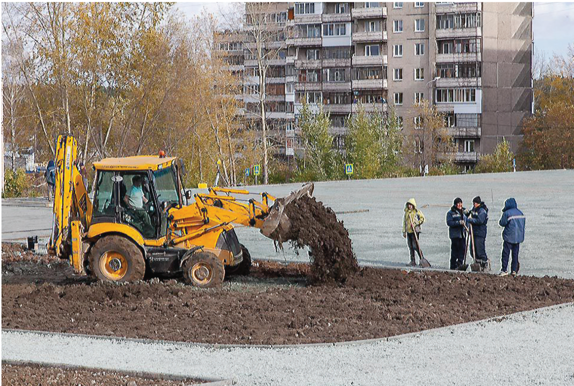
Основная часть работ выполнена.
