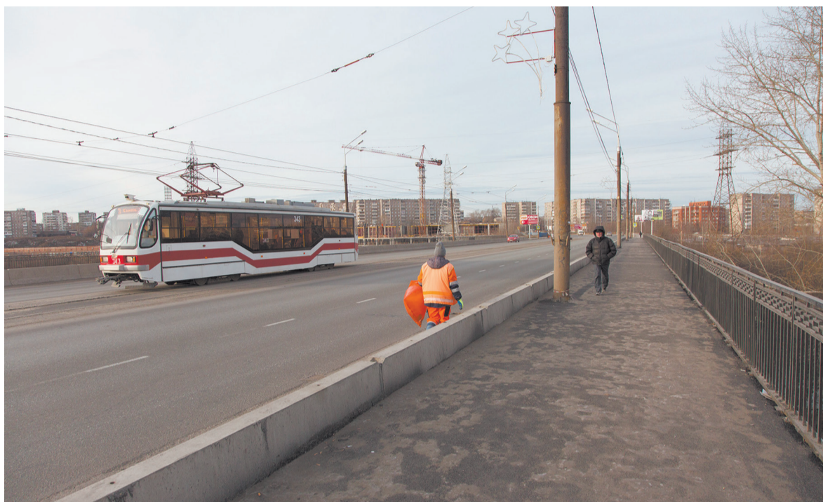
Мост на улице Космонавтов.
