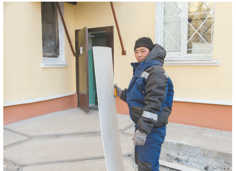
Рабочий-кореец мостит новые, очень удобные ступени на входе в подъезд.
