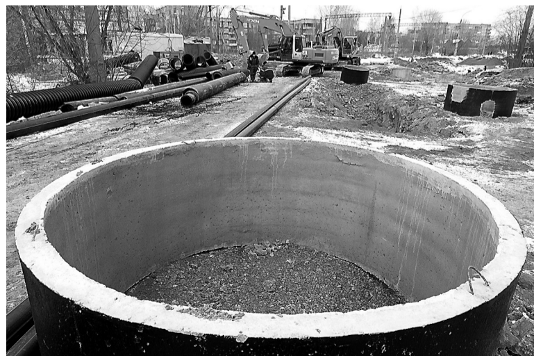
Улица Быкова. Идет замена труб водопровода и канализации.
