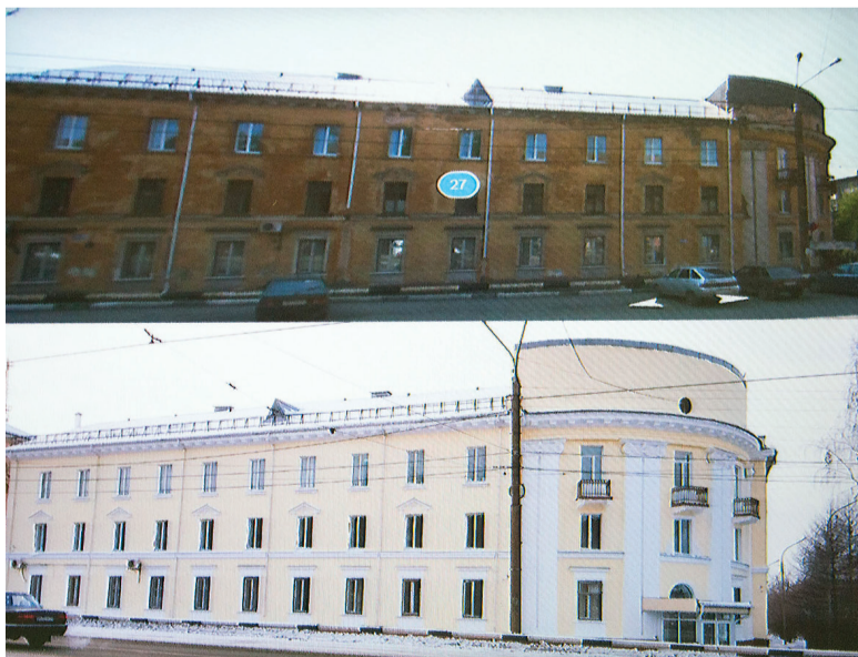
Есть немало успехов в проведении ремонтов городских ЛПУ. К примеру, здание женской консультации на проспекте Мира: каким было и каким стало.
