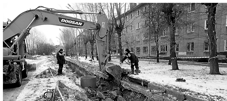
Строительство ливневой канализации на Грибоедова.
