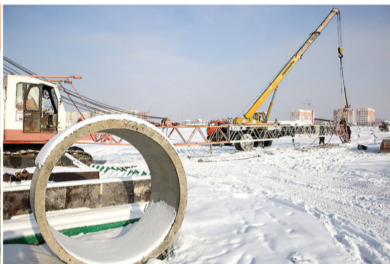
На строительной площадке работает техника.
