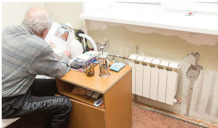
В отделении пульмонологии заменили систему отопления. Вскоре здесь проведут ремонт.
