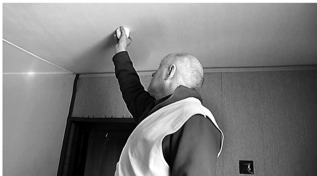
Установка пожарного извещателя.
