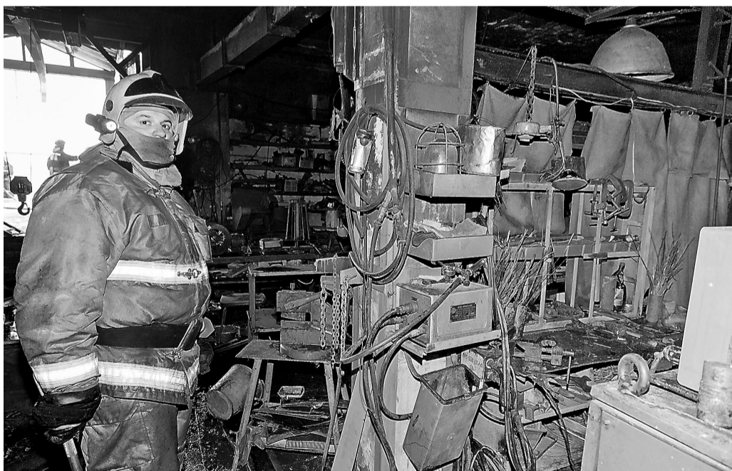
Последствия пожара в НТИ(ф) УрФУ. ФОТО СЕРГЕЯ КАЗАНЦЕВА.
