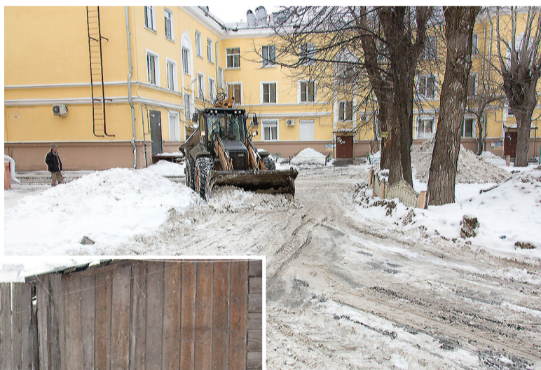
Расчистка двора на Ленина, 52.
