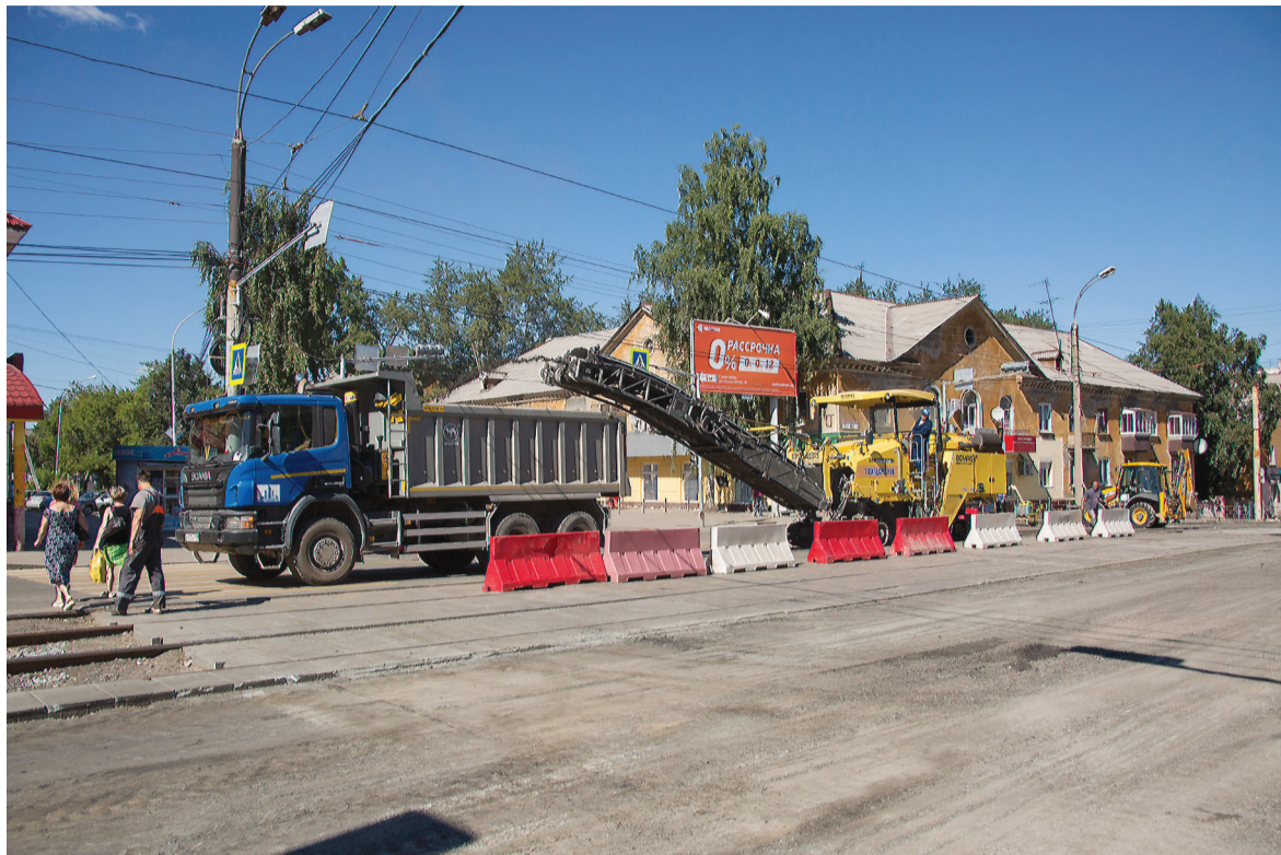
На перекрестке Красноармейской – Космонавтов снимают асфальт.
