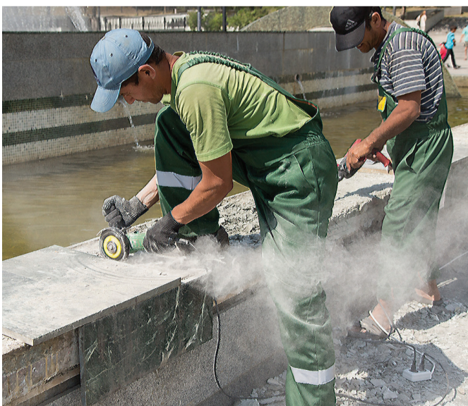
Подрядчику необходимо полностью обновить облик фонтана.
