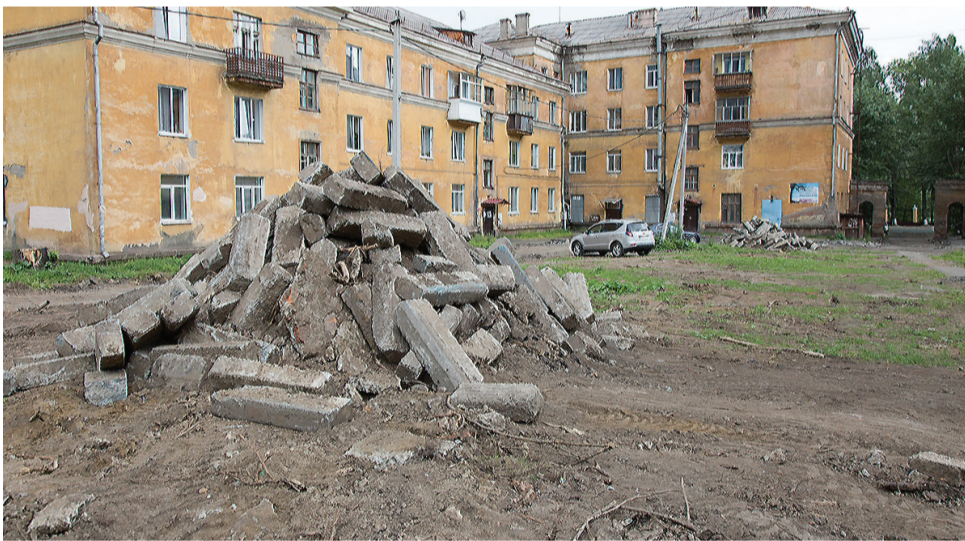
Такой пейзаж успел надоесть жителям двора на пересечении улиц Металлургов, Технической и Кутузова. 31 июля здесь появился экскаватор – начали вывозить демонтированные конструкции.
