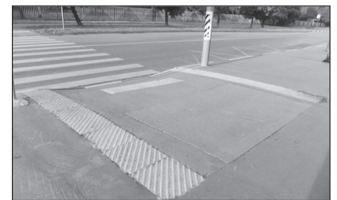
Рисунок 39. Пример укладки тактильной плитки для обозначения пешеходного перехода
