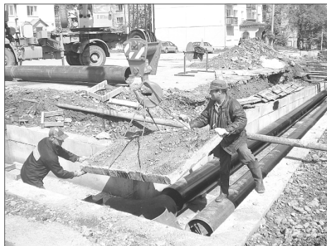
Идет реконструкция участка теплосети у Дворца культуры металлургов
