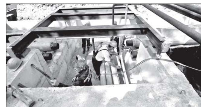
ограждения, ведутся земляные и демонтажные работы, смонтирован временный трубопровод для обеспечения потребителей горячей водой. Энергетикам предстоит смонтировать 900 метров нового трубопровода диаметром 600
