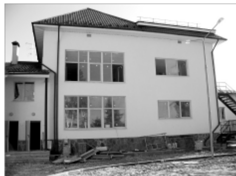
Здание детского сада в селе Новоалексеевском.
