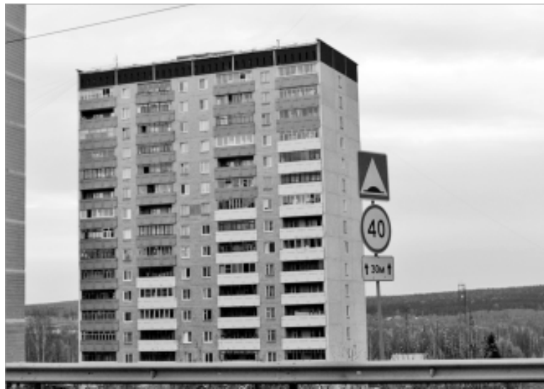
Издали дом № 5 по улице Емлина выглядит вполне ухоженным. Из его окон, выходящих на Чусовую, открывается прекрасный вид.
