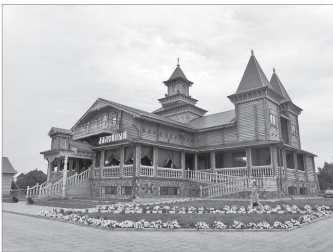
Многие рестораны в Тобольске - полностью деревянные.
