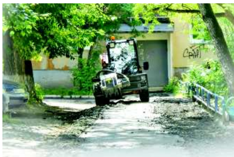
Так было на ул. Трубников во второй день работ. Дорога уже построена.
