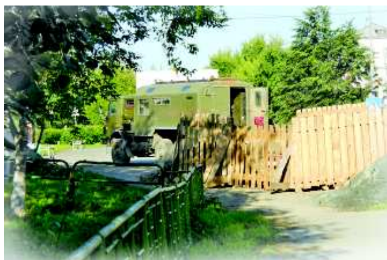
Скоро котлован заровняют и ограждение уберут.
