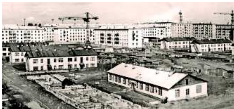
Строительство 1-го квартала и снос "ворошиловских" домов.
