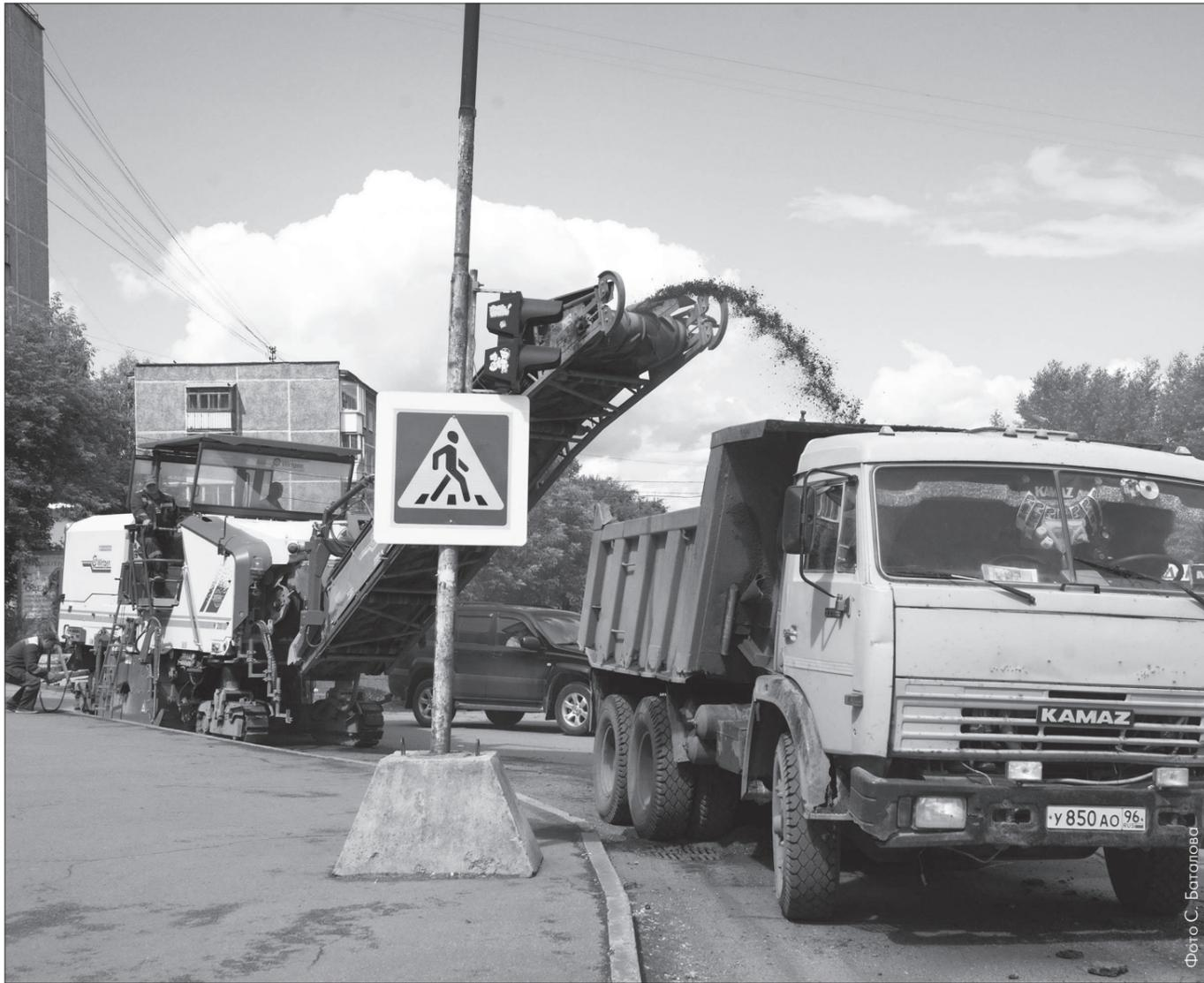
Дорожная фреза снимает старое асфальтовое покрытие.
