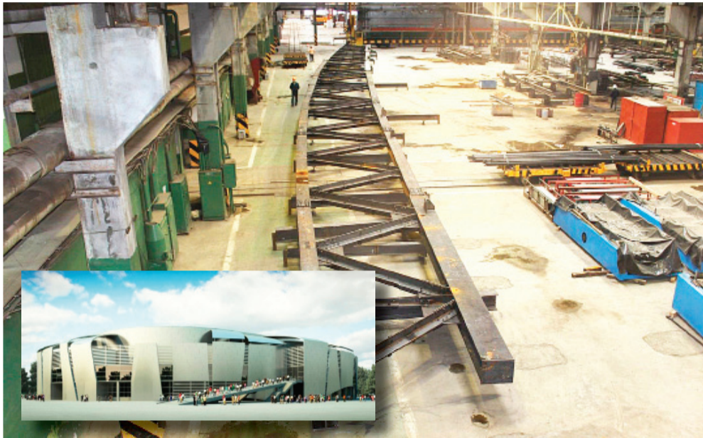
Контрольная сборка фермы Малой ледовой арены на производственной площадке металлоконструкций
