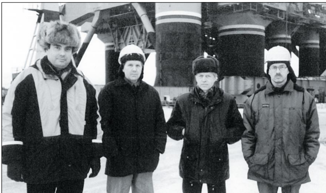
Монтаж и испытания оборудования космической программы «Морской старт». Третий слева – В. Ф. Суетин. Выборг, 1998 год.
