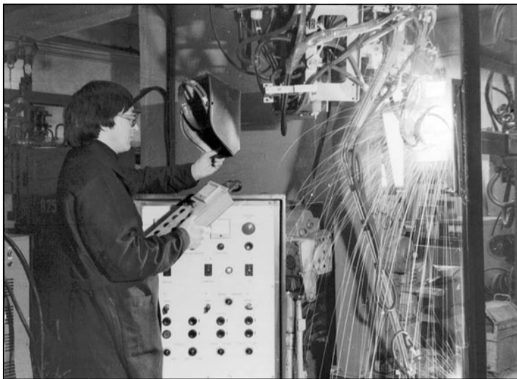
Испытания автомата АД-164 для сварки вертикальных швов вагона. 1980-е.
