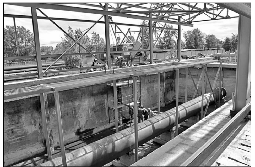
Строительство новых очистных УВЗ.
