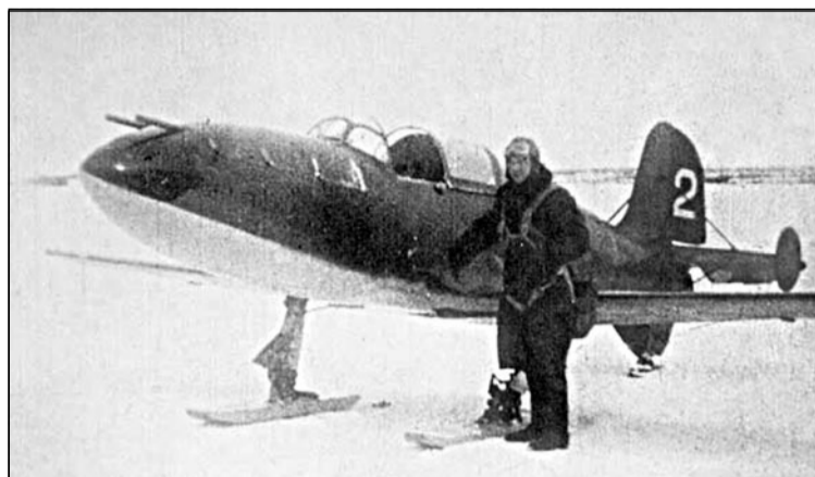
Самолет «БИ-1», второй образец: вместо шасси установлены лыжи. Рядом – Г. Я. Бахчиванджи.
