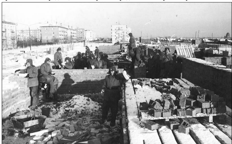
Строительство дома №25 по ул. Ломоносова. фото Волковой Г.Н.
