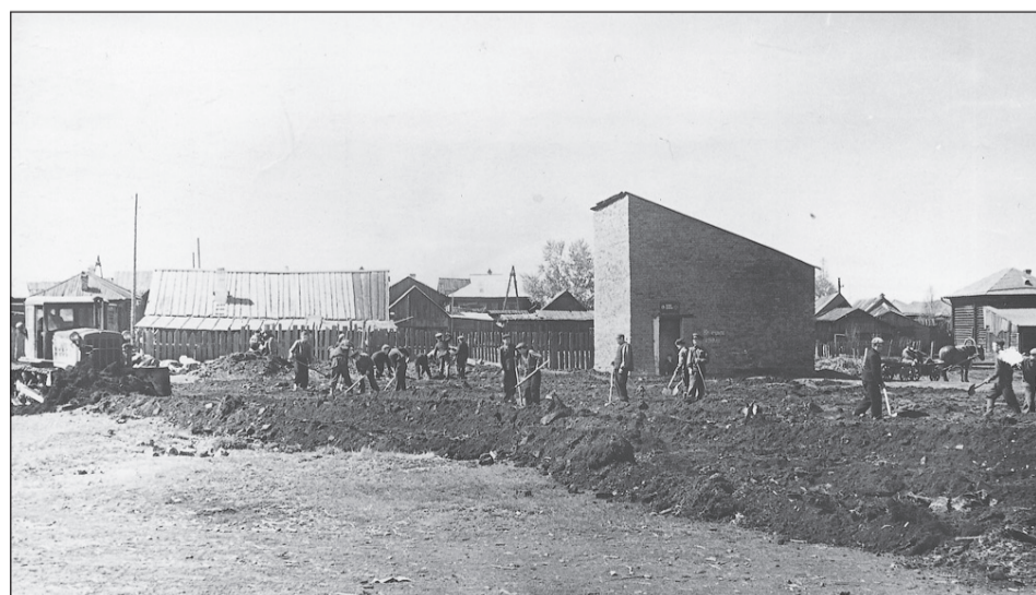
Строительство городской бани на ул. Урицкого.
