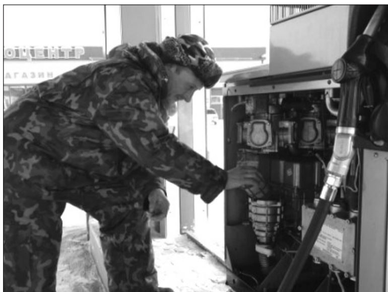
Через фильтр тонкой очистки топлива на резервуаре – наше ноу-хау – бензин поступает на входной фильтр ТРК и наконец (!), через пистолет, в котором также установлен фильтр из мелкой сеточки, заливается в бак Вашего автомобиля.
