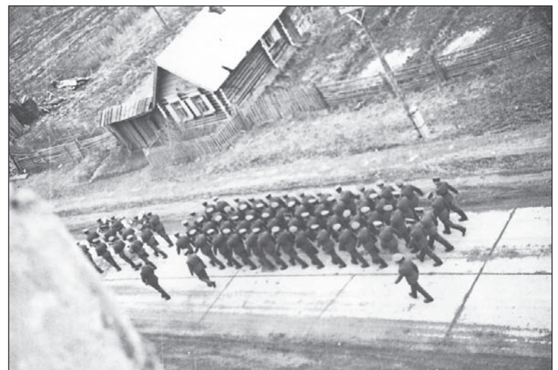
Снято со строящегося дома №15 по ул. Ломоносова в конце 70-х.
