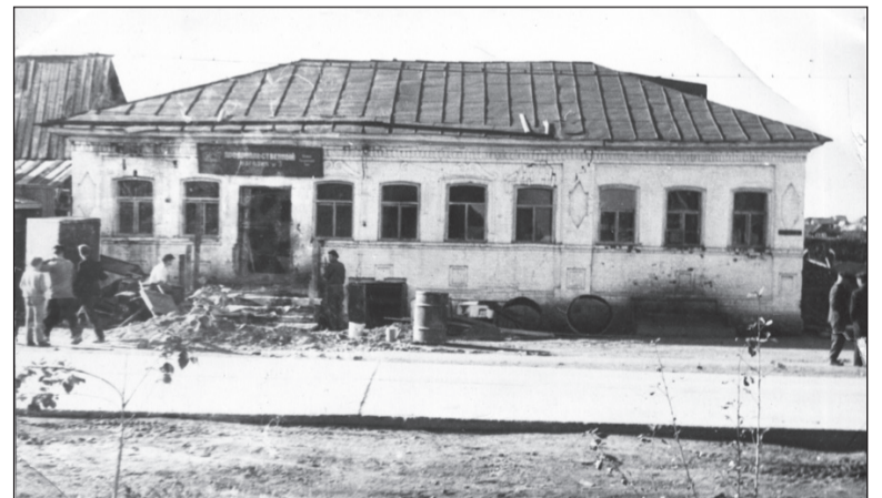
Ремонт магазина по ул. П.Коммуны, 1963 г.
