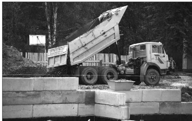
Закладку фундамента планируют завершить к 5 сентября.
