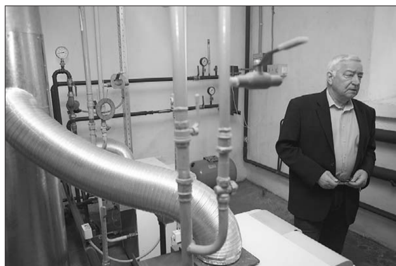
Юрий Галынт демонстрирует новую котельную.
