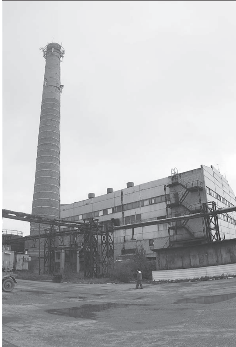
Котельная к пуску тепла готова.
