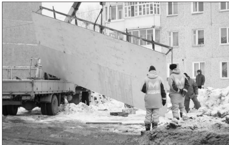
Плановый демонтаж металлической конструкции
