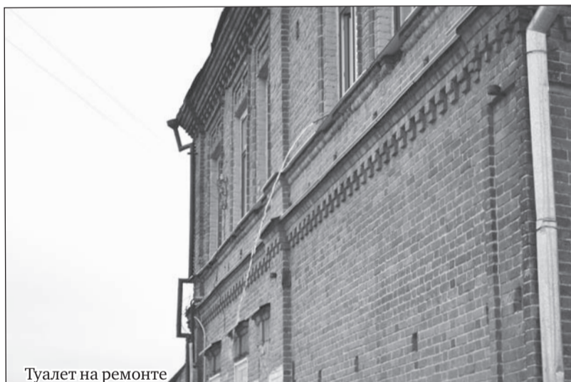
Туалет на ремонте
