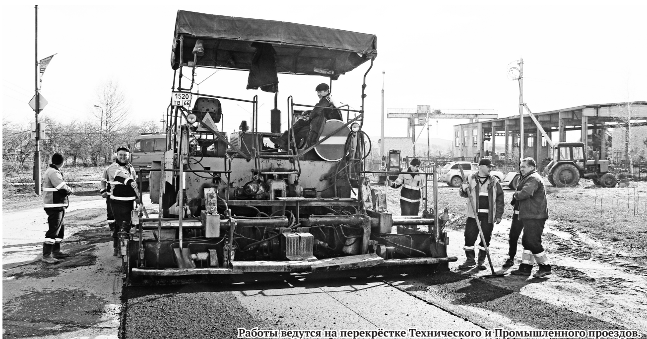
Работы ведутся на перекрёстке Технического и Промышленного проездов.
