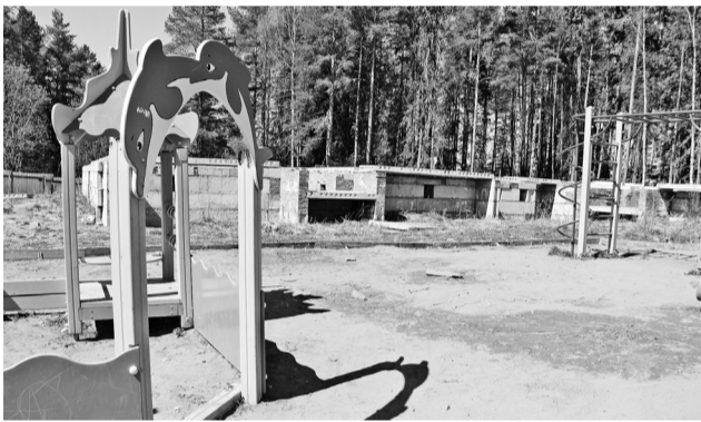
Заброшенная стройка и детская площадка – опасное соседство.
