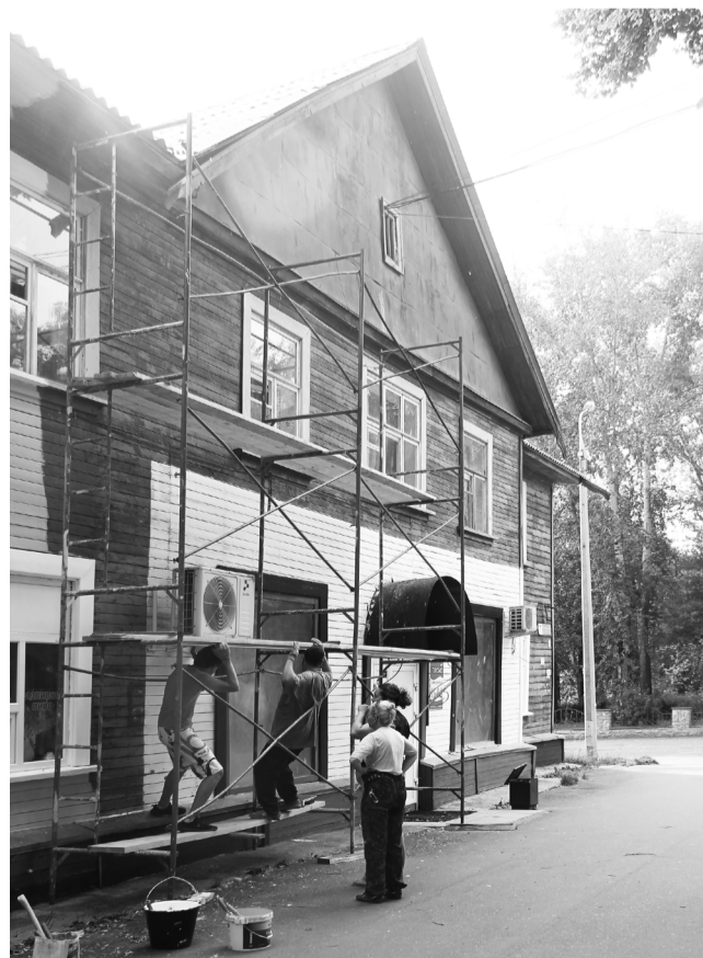
В доме по адресу Компроспект, 7 ремонт фасада выполнен на 15%, а ремонт крыши – на 75%.
