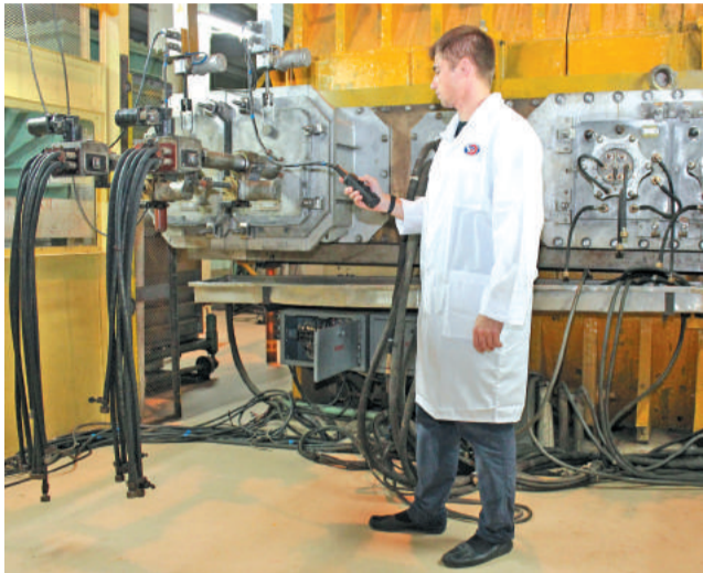
Специалист комбината «Электрохимприбор» выполняет проверку первого контура установки Е-7.
