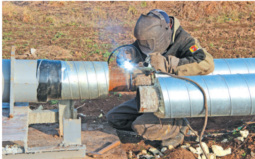
Стыковка швов трубопровода.
