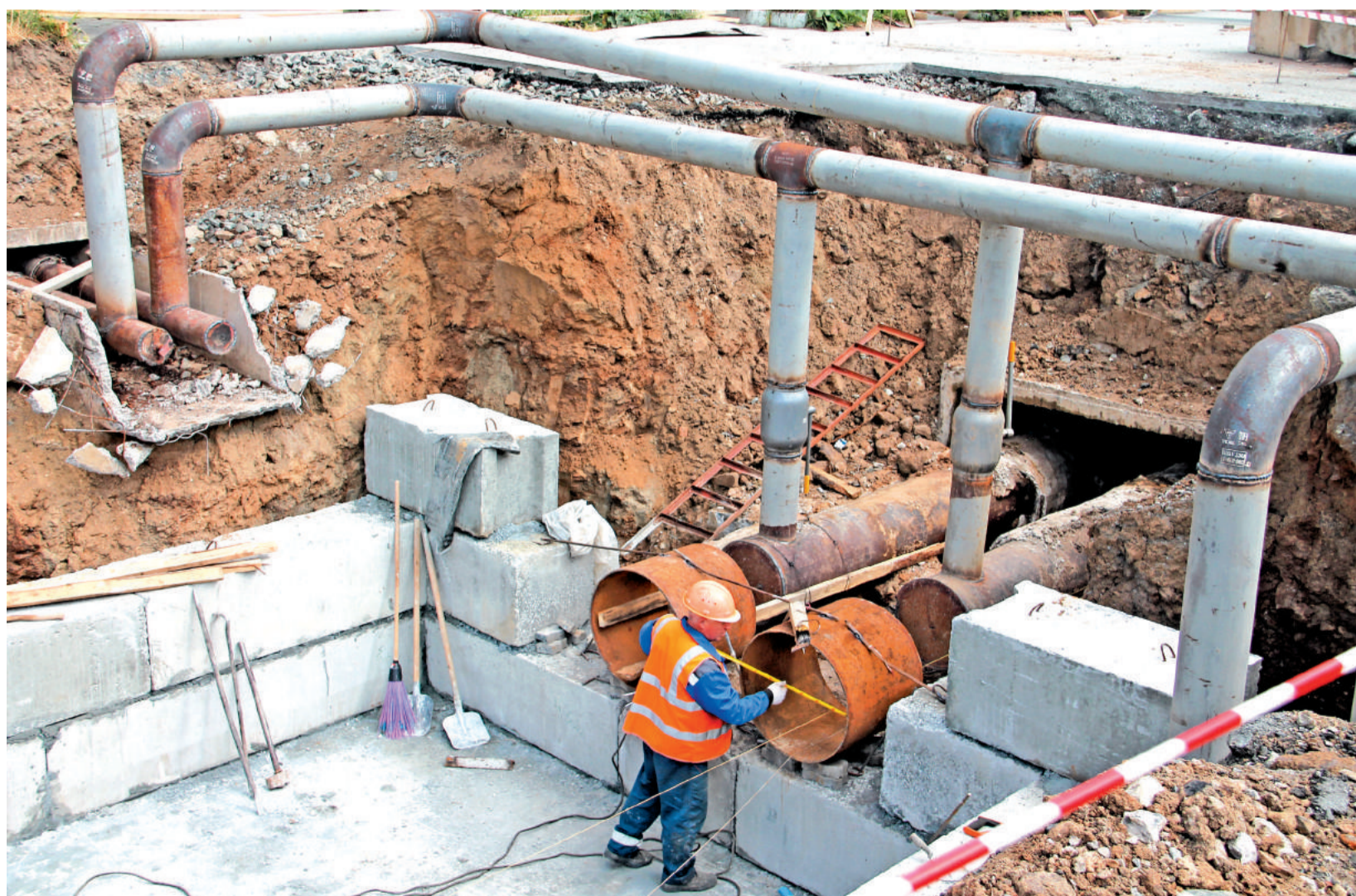
Идёт монтаж тепловой камеры. Теперь она будет собрана из монолитной плиты и железобетонных блоков, толщина стен которых - 600 мм.
